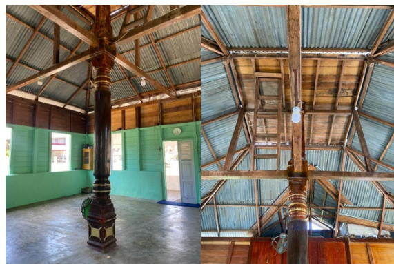
Gambar 11. Tiang utama pada masjid
