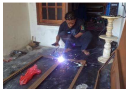
Gambar 3. Pembuatan frame besi
