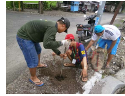
Gambar 14. Pembuatan lubang tanah untuk pemasangan tiang
