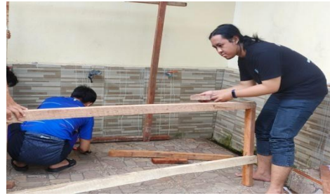
Gambar 3. Pembuatan penyangga instalansi hidroponik
